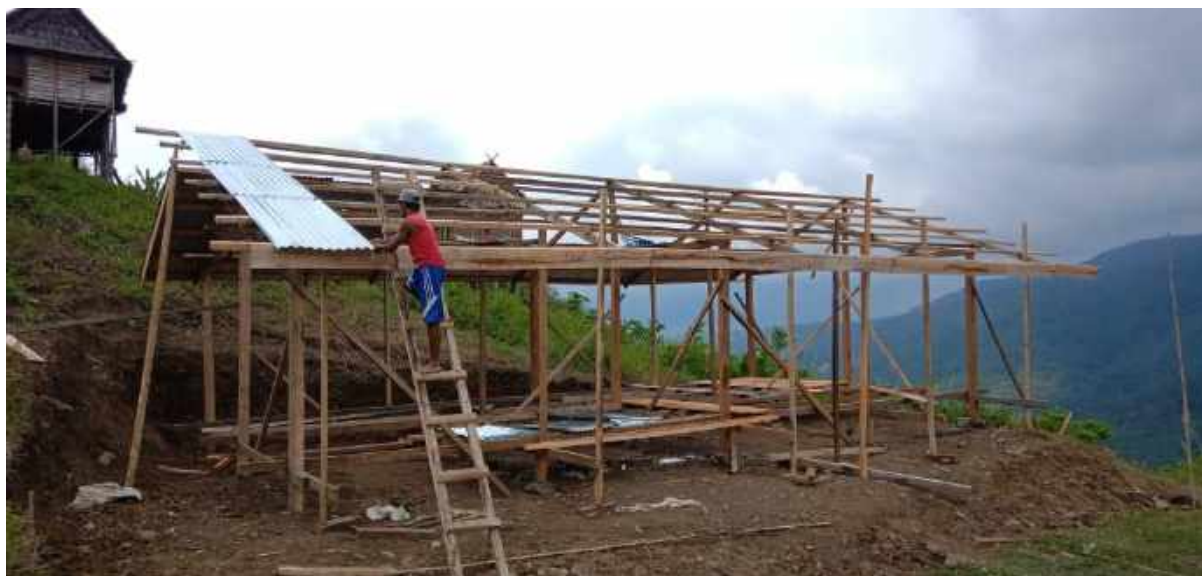
Gambar 1. Proses pembangunan Gedung Rumah Baca
